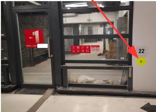
Positionner les ancrages pour pouvoir établir une ligne guide continue depuis l'extérieur, niveau d'accès des secours, jusqu'au PC de sécurité ou local d'exploitation.
