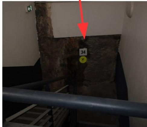
Dès la sortie escalier dans un niveau, positionner 2 ancrages. Un de chaque côté de la porte.
