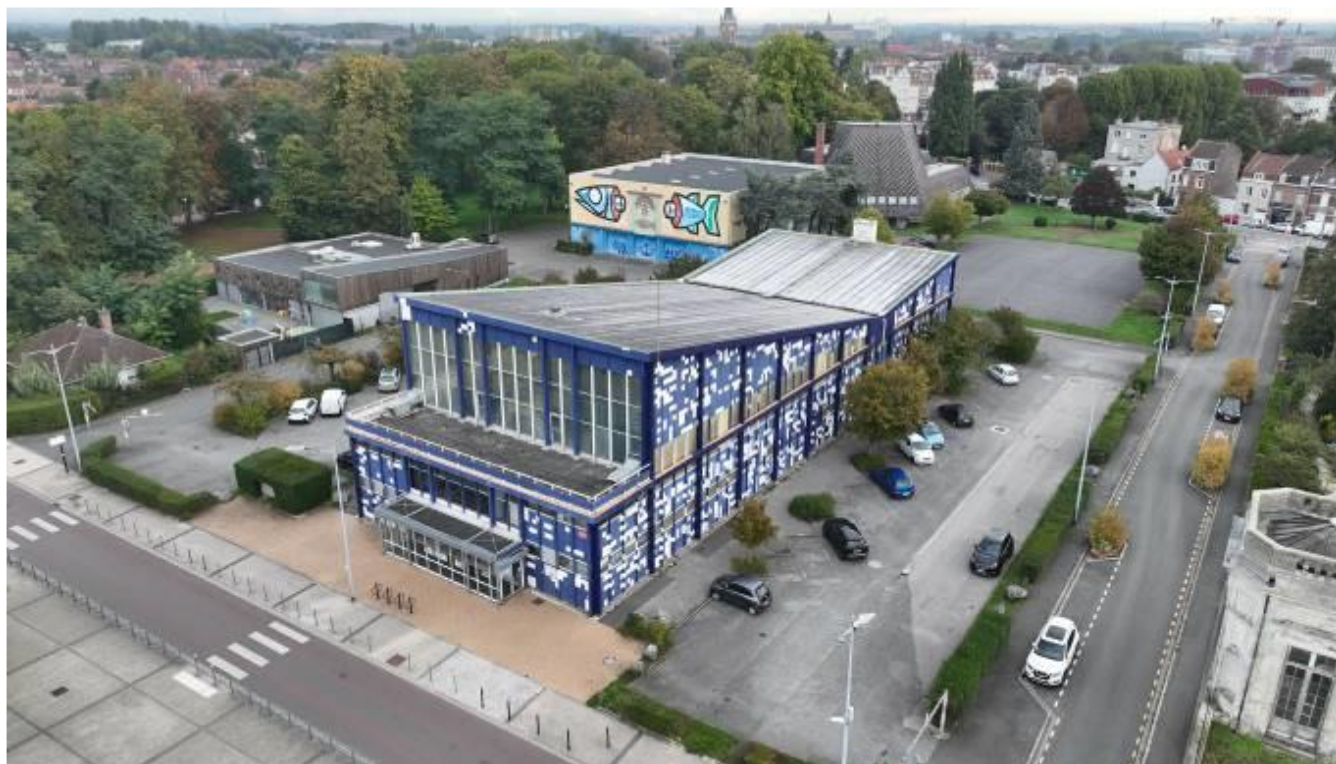
PISCINE MUNICIPALE, 32 RUE VAUBAN, SAINT ANDRE LEZ LILLE(59)
