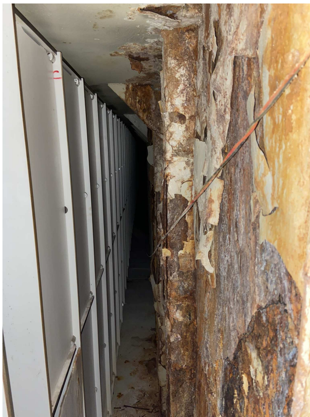
« Charpente derrière casier »
