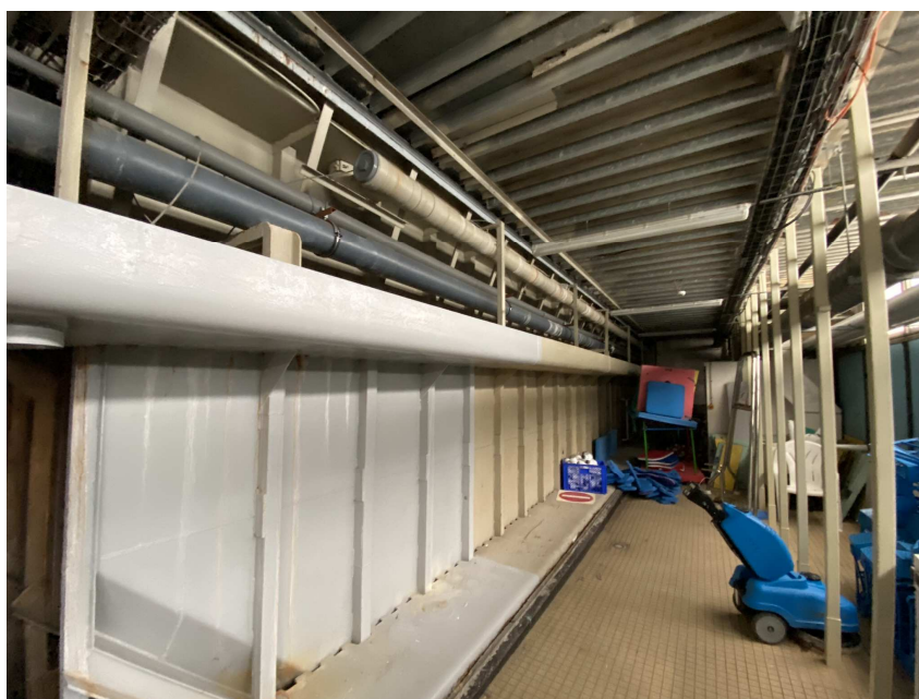
« Charpente côté droit, moins atteinte »
