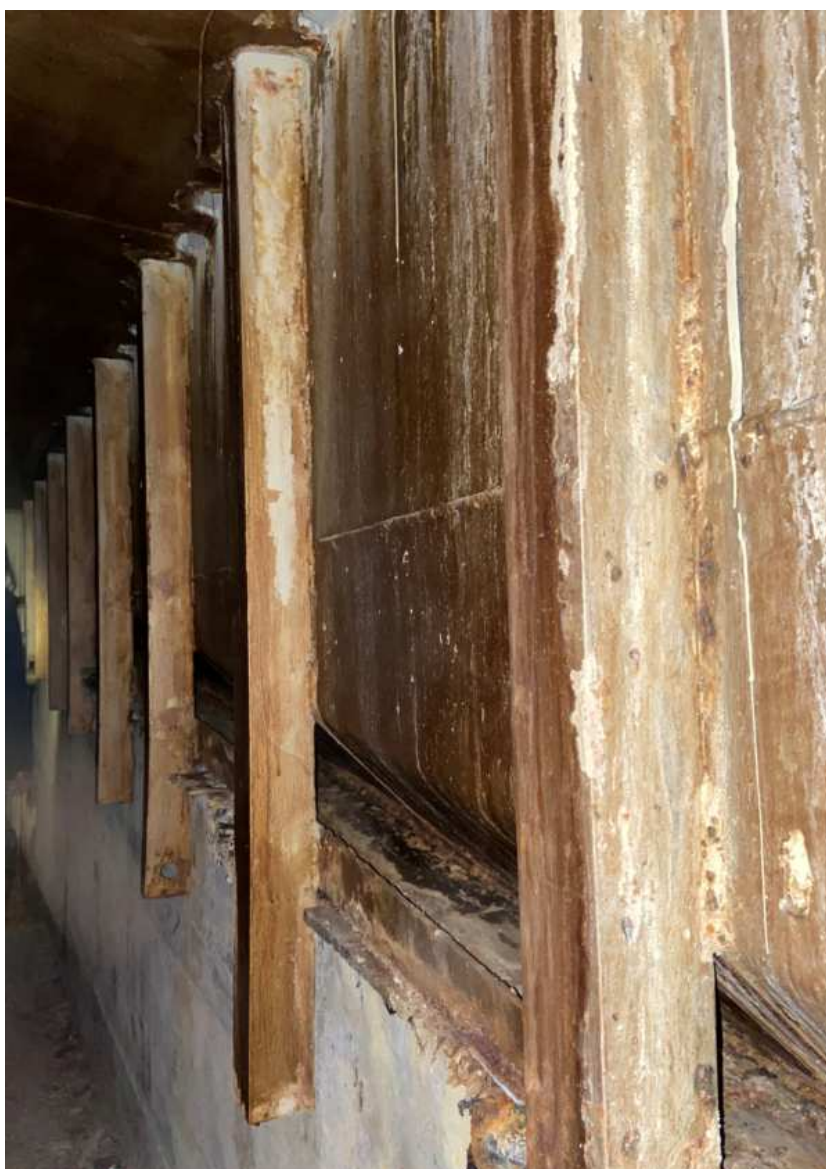
Le grand bassin pose sur les murs en béton.
