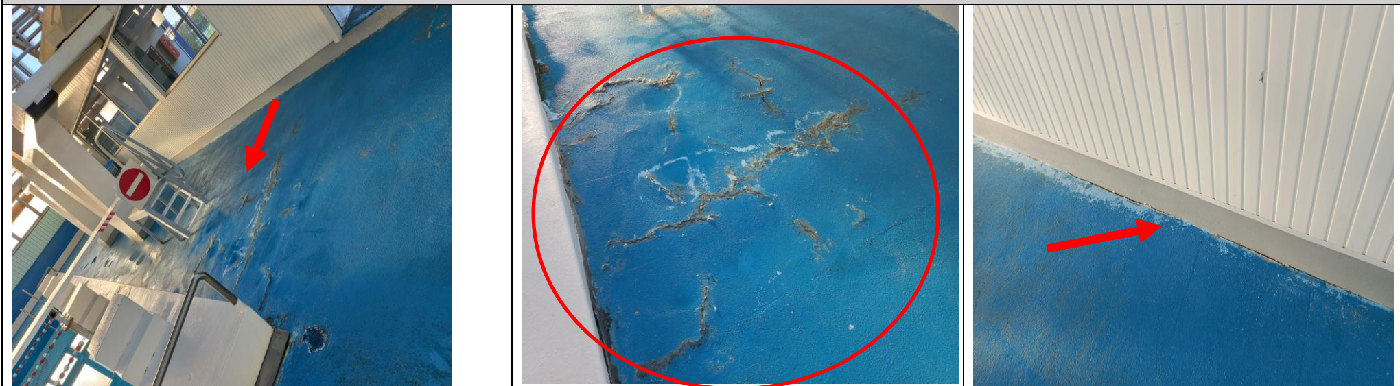
Photos – Membrane d'étanchéité
