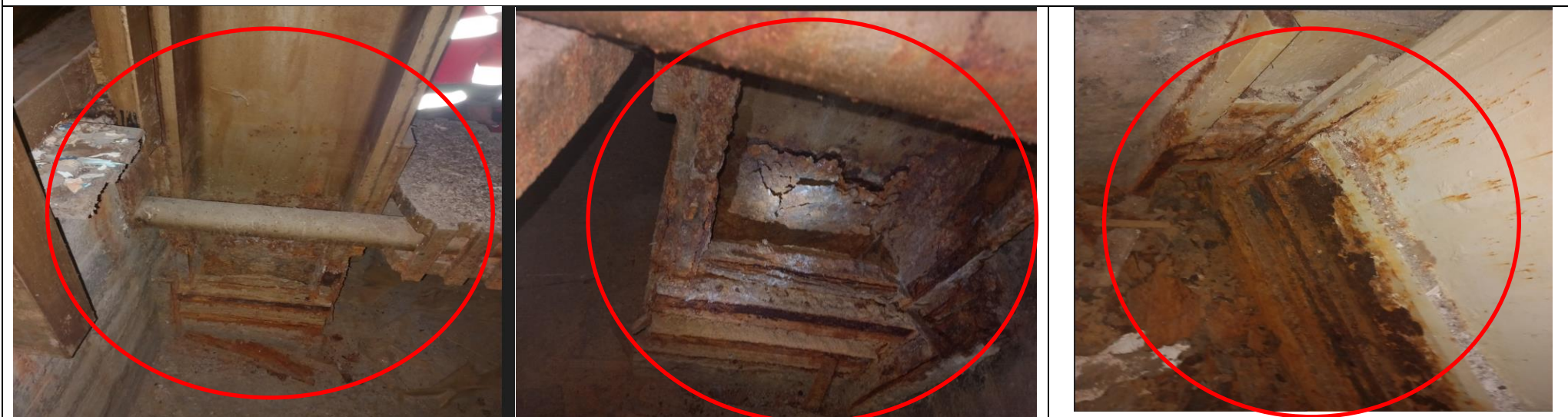
Photos – Désordres – Poteaux, tirants métalliques et Massifs béton
